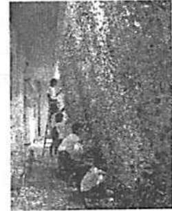
写真②：作業の様子
